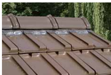
Țigle cu suprafață plană și cu ondule mici
